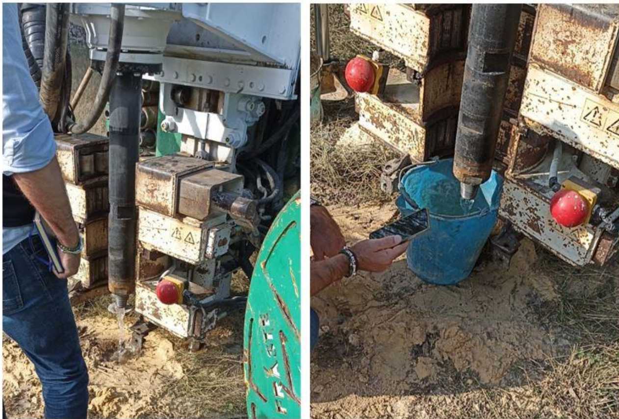
Figura 21 A sinistra, immissione del fluido in foro di sondaggio e monitoraggio del livello; a destra, misura della portata Q di prova.
