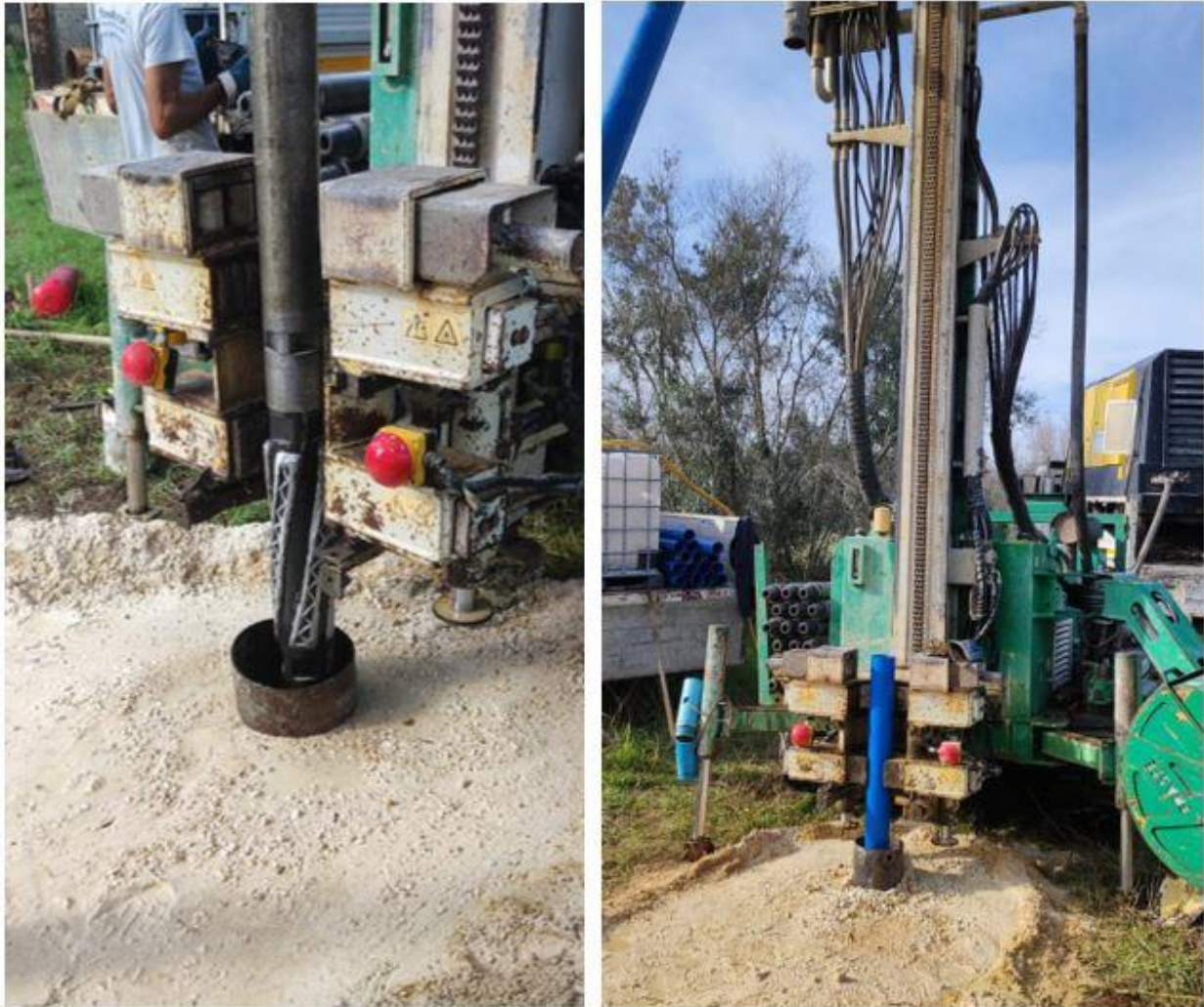
Figura 15 Fasi di realizzazione dei piezometri
