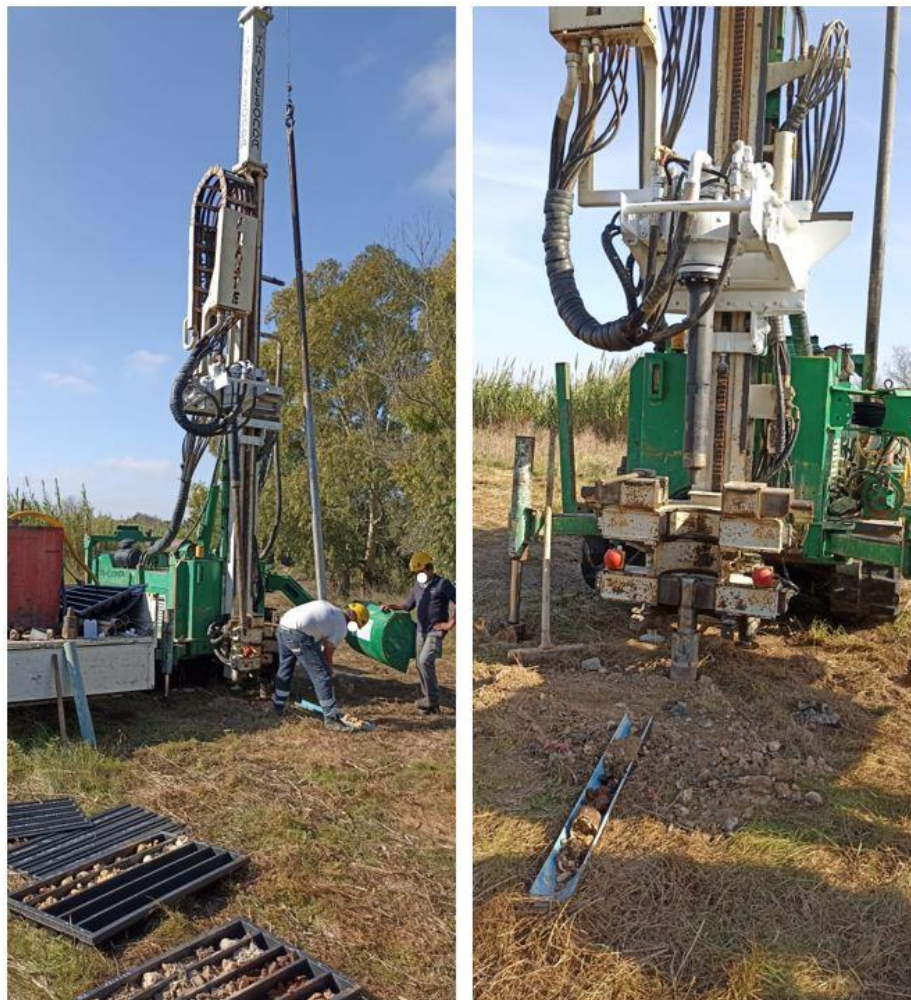
Figura 12 Fase di terebrazione dei sondaggi geognostici
